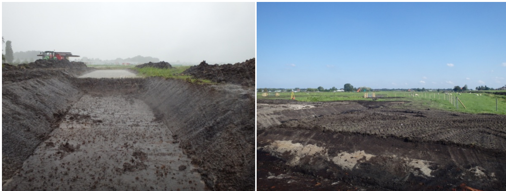
Afb. 3. Impressie van de werkzaamheden in verschillende weersomstandigheden.
